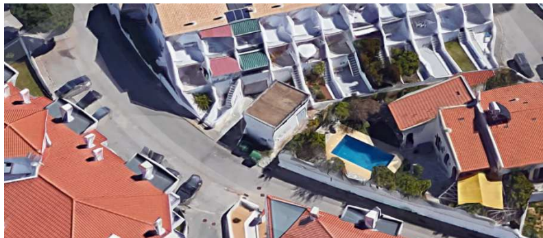
Figura V.2.2. Posto de transformação da EDP
